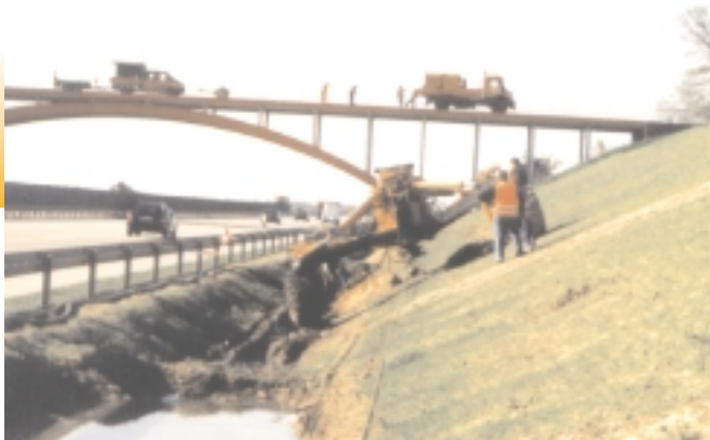
Pluhování podél dálnice
