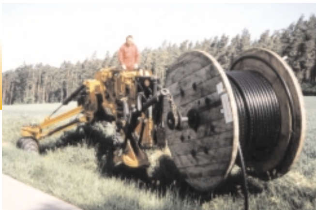
Pluhování přímo z kotouče s návinem
