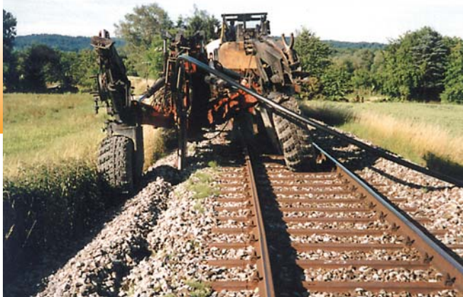
Einpflügen entlang Bahnstrecken
