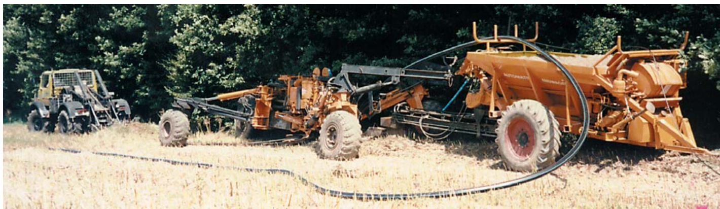
Pose d'une canalisation d'eau Ø 180 mm
