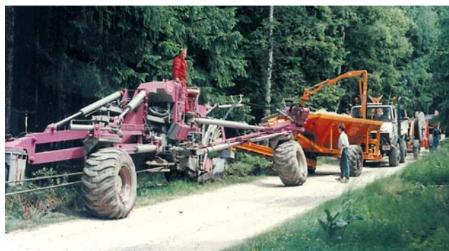
Pose d'un câble électrique de moyenne tension
