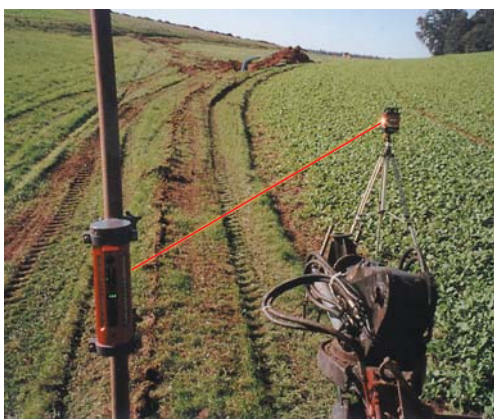
Pose au niveau laser
