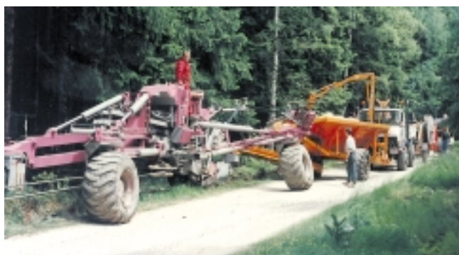
Posizionamento di un cavo ad alta tensione usando il carro automatico d'insabbiamento
