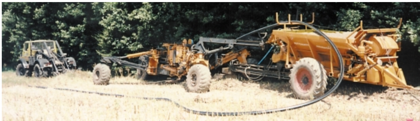
Aratura di un tubo dell'acqua con un diametro esterno di 180 mm/[7"] usando il carro automatico d'insabbiamento
