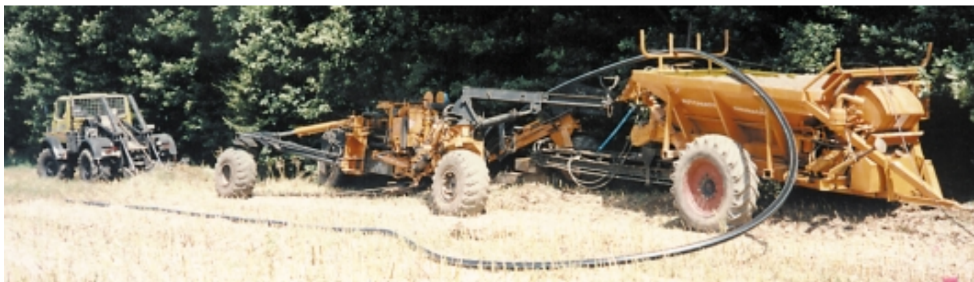
Introducerea unei conducte de apă cu un diametru exterior de 180 mm/(7") folosind dispozitivul de astupare automată
