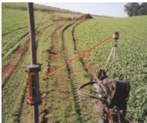
Introducerea cablurilor și conductelor cu ajutorul laser-ului și GPS-ului
