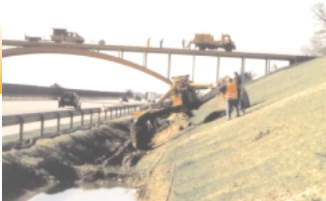
Instalarea de-a lungul unei autostrăzi
