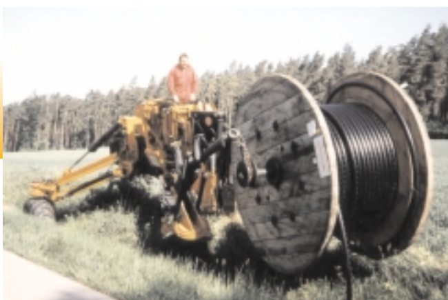
Instalarea direct de pe tambur
