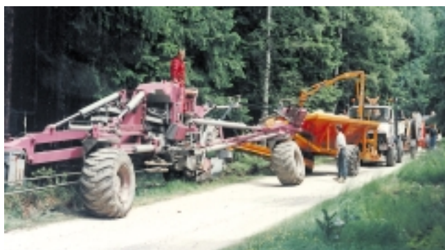
Introducerea unei conducte de apă cu un diametru exterior de 180 mm/(7") folosind dispozitivul de astupare automată
