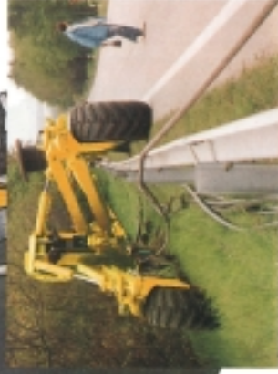
Прокладка кабеля за дорожным ограждением
