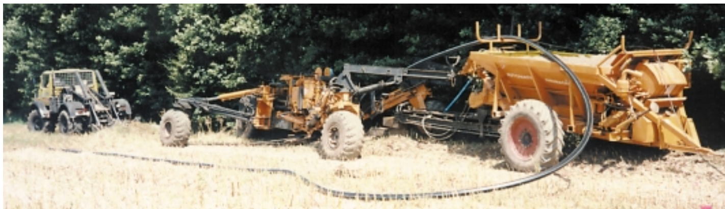
Прокладка водопроводной трубы внешним диаметром в 180 мм с использованием автоматической установки для засыпки песка
