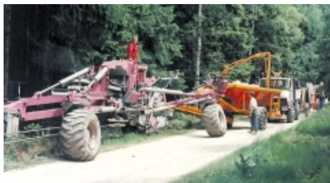
Прокладка высоковольтного кабеля с использованием автоматической установки для засыпки песка
