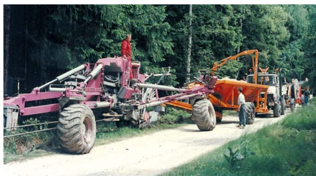
Tendido de un cable de alta tensión utilizando el carro de engravillado automático
