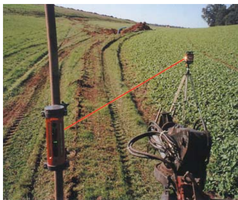
Soterramiento con láser circular y GPS
