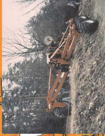
Soterramiento a lo largo de una pendiente
