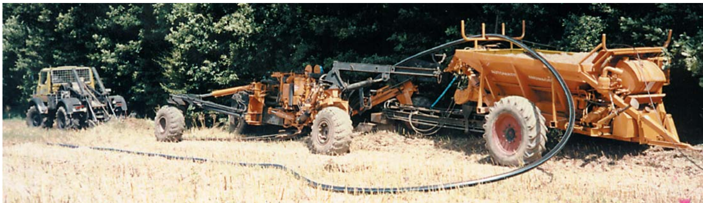
Soterramiento de una tubería de agua con un diámetro exterior de 180 mm/[7"] con el carro de engravillado automático
